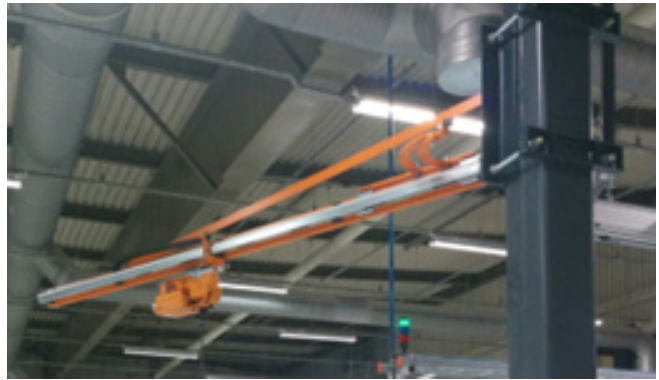
Pilariin asennettu ja energiaketjulla varustettu puominosturi
